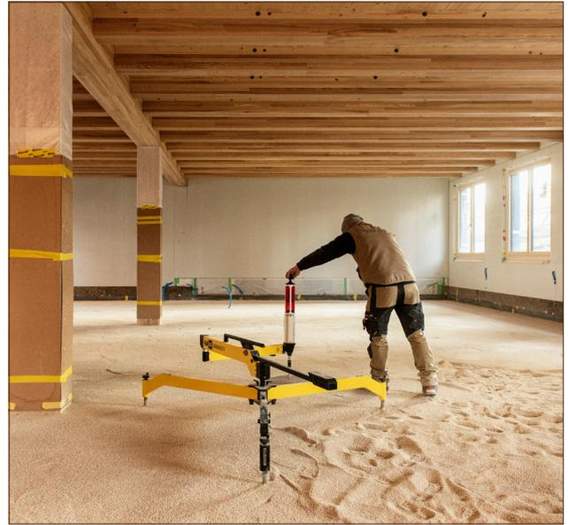
Die speziell entwickelten Sensoren des Aktuators erfassen den Laserstrahl (roter Strahl) jedes handelsüblichen Rotationslasers.
